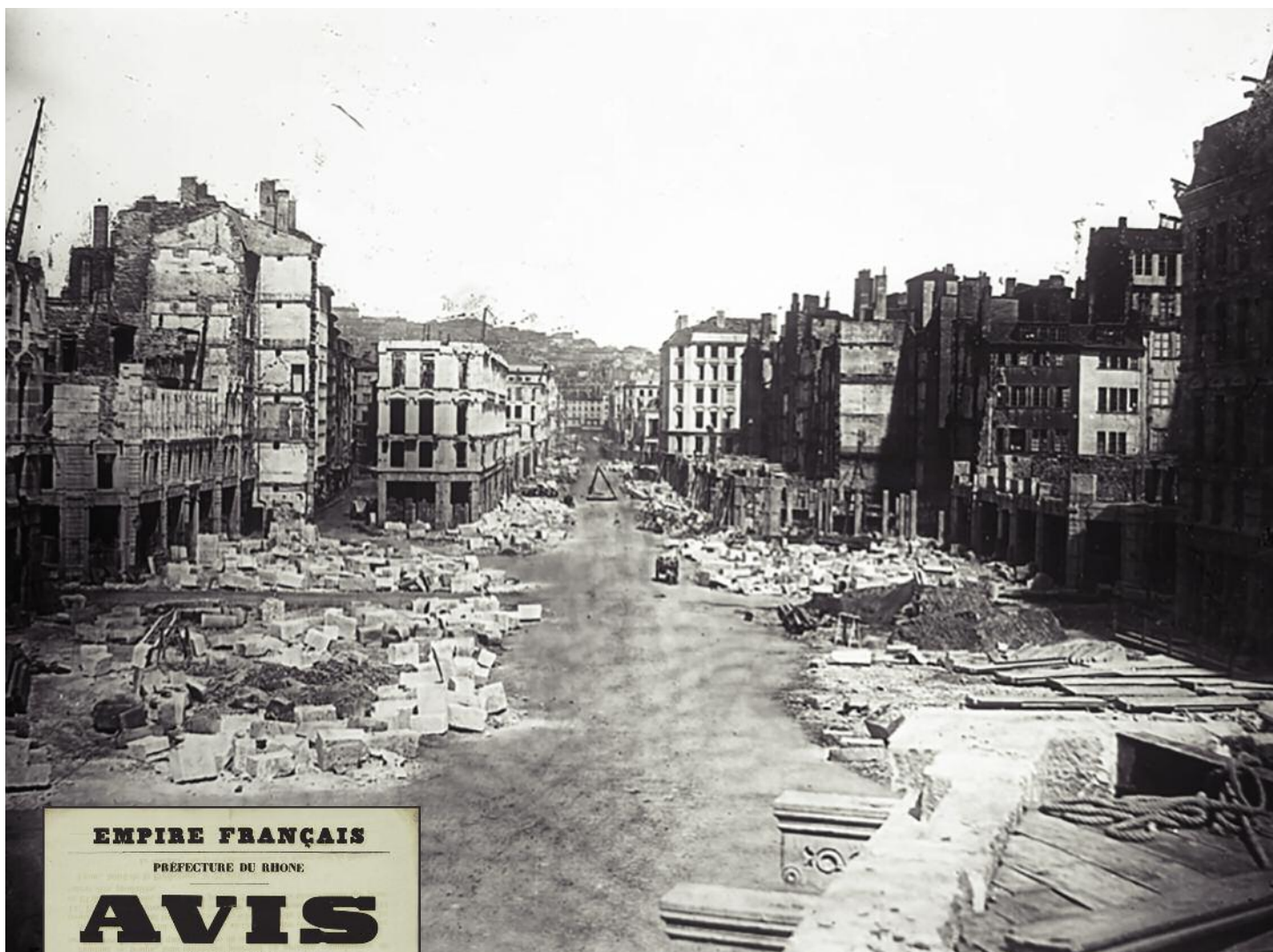
Démolition du quartier BML - P0546 S 3387
