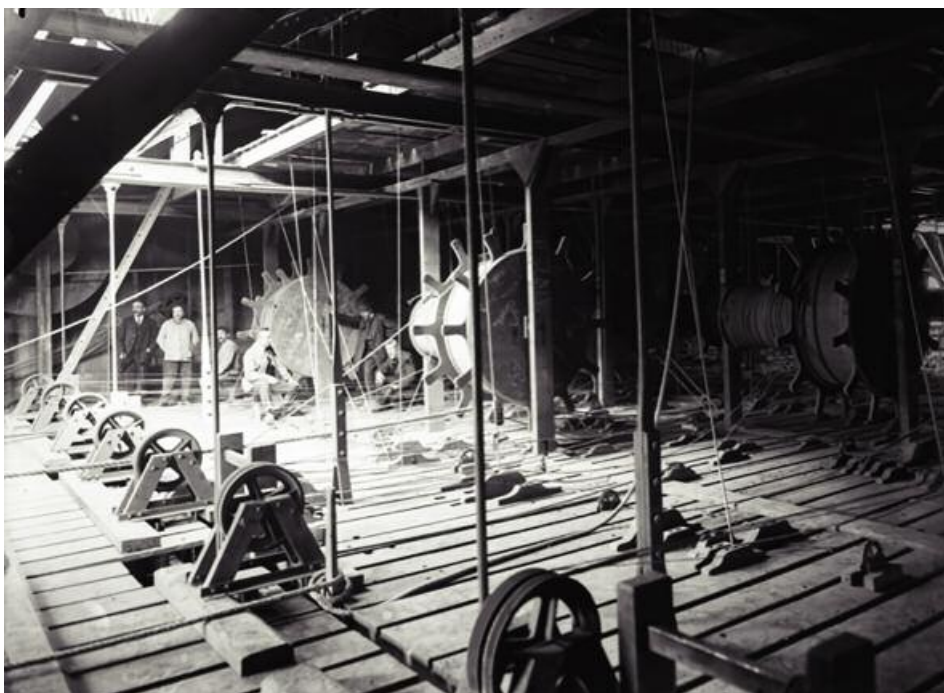
Réfection intérieure du Grand-Théâtre de Lyon : armature métallique du plateau supérieur de la double scène tournante en cours de montage. Démolie et remplacée en 1961. BML / P0546 S 2275
