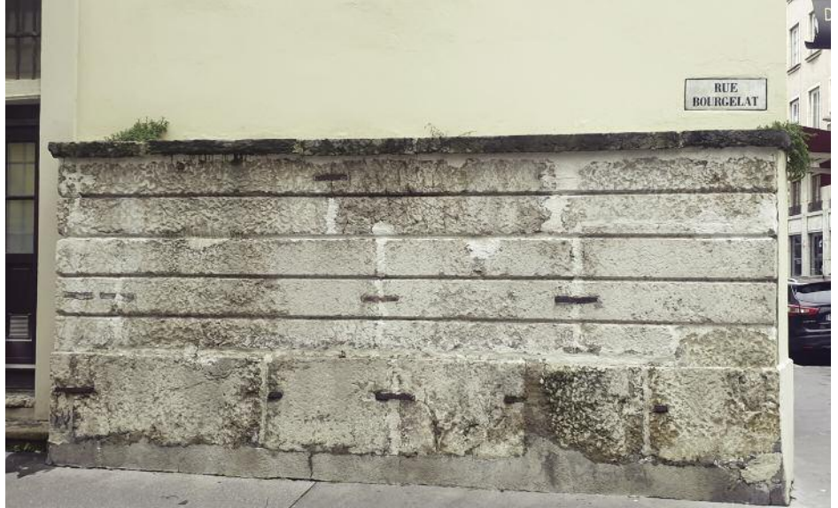
Vestige du rempart du XVIIème siècle, rue Bourgelat.
