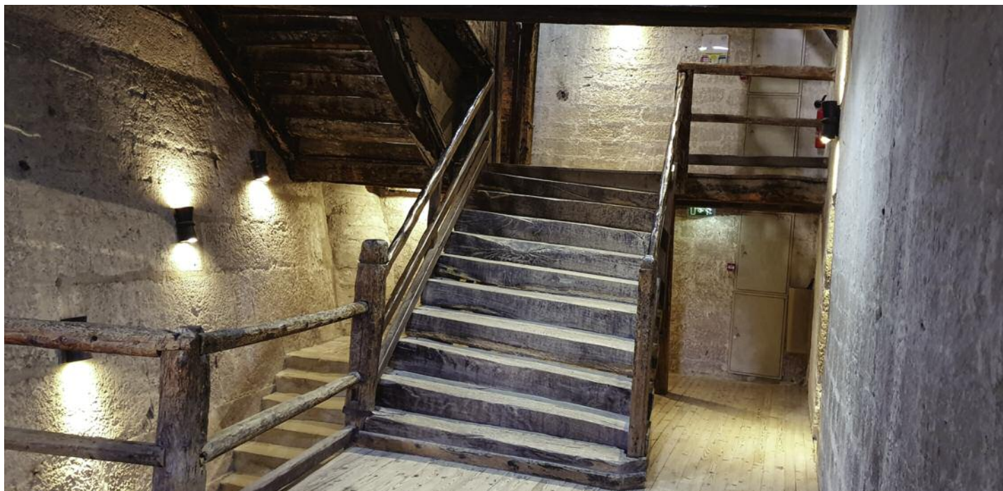
Escalier en bois qui accède au premier niveau
