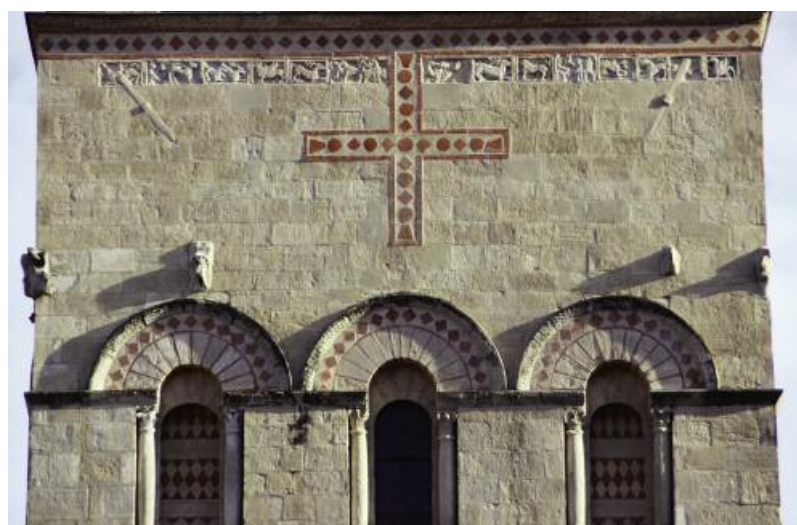
Troisième niveau du clocher-porche : moyen appareil, carreaux sur la pointe, bas-reliefs en frise. Deux fenêtres ont été murées afin de consolider la structure de l'ensemble.
