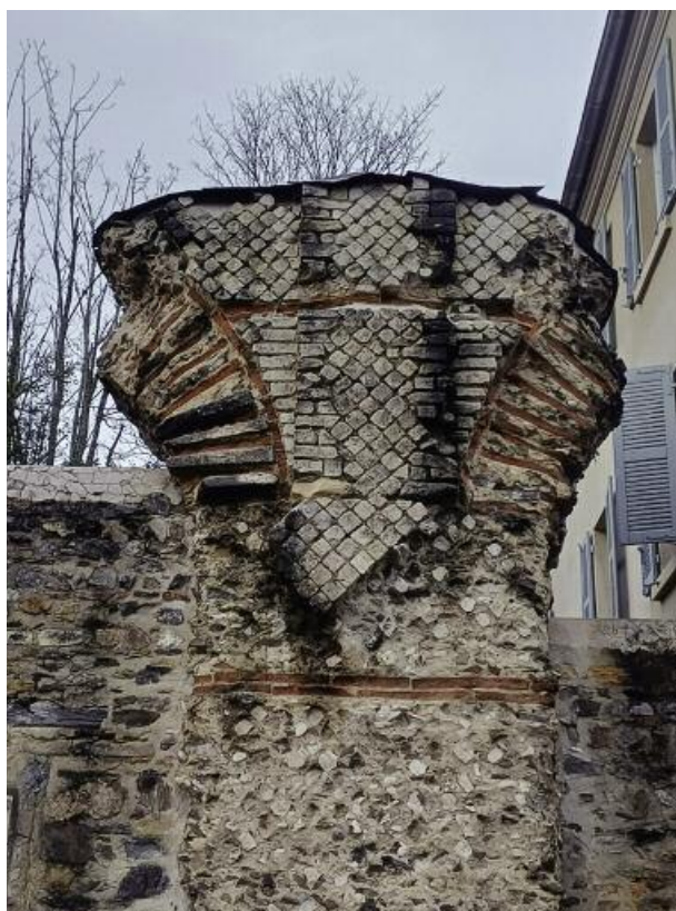
Appareil réticulé* - Aqueduc du Gier rue Radisson Lyon 5ème
