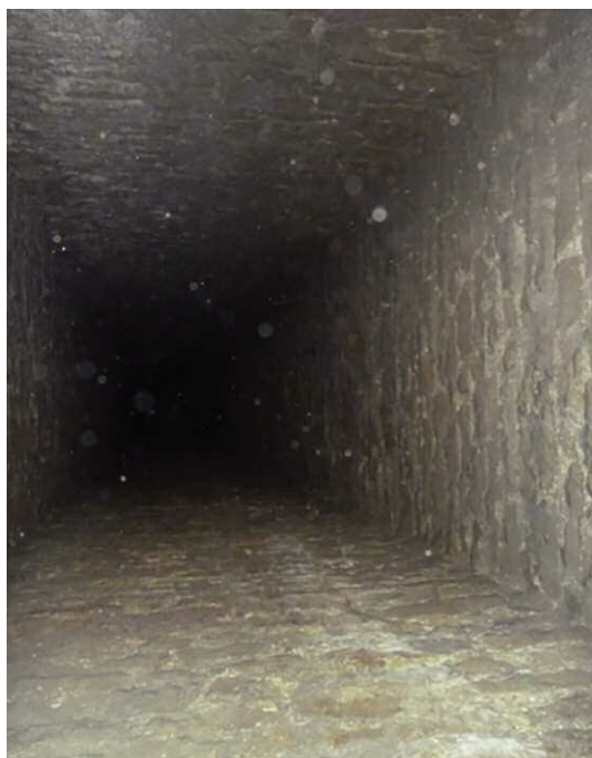
Figure 12 : un des puits d'accès aux arêtes (D. Frascone)
