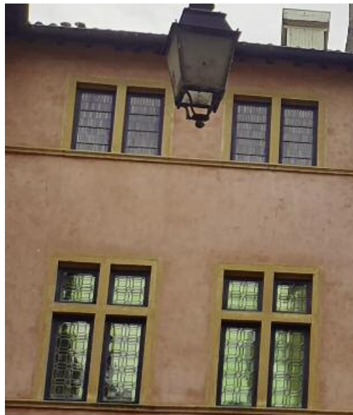
Les rehauts du XVII e montrent des fenêtres à meneaux et traverses à arêtes vives, sans moulures, qui témoignent de cette époque.
