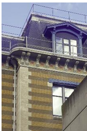
Albert Constantin a voulu conserver l'esprit industriel de la Manufacture des tabacs : les linteaux en fonte de couleur bleu ont été mis en valeur, les fenêtres ont été démontées et remplacées par d'autres en bois avec un meneau vertical métallique gris, purement décoratif, pour réintroduire un peu plus de métal et se raccrocher à l'aspect industriel. (5)
