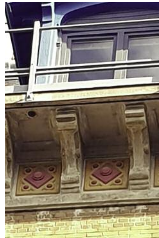
Albert Constantin a voulu conserver l'esprit industriel de la Manufacture des tabacs : les linteaux en fonte de couleur bleu ont été mis en valeur, les fenêtres ont été démontées et remplacées par d'autres en bois avec un meneau vertical métallique gris, purement décoratif, pour réintroduire un peu plus de métal et se raccrocher à l'aspect industriel. (5)
