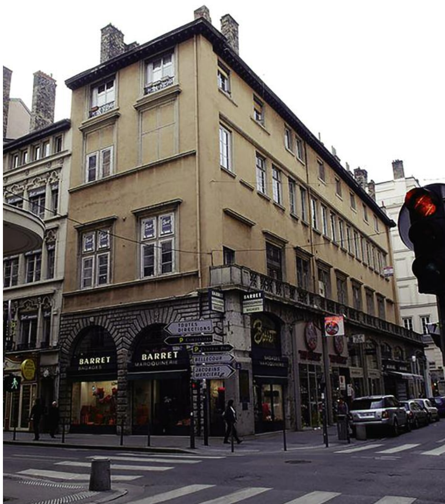
Halle aux grains ou loges de la grenette ou Grenette. Angle rue Grenette et rue de Brest. Du XV ème au XVI ème siècle la Grenette a servi d'entrepôt aux grains et de marché. En effet, deux fois par semaine, s'y rencontrent les revendeurs de blé et de pain.
